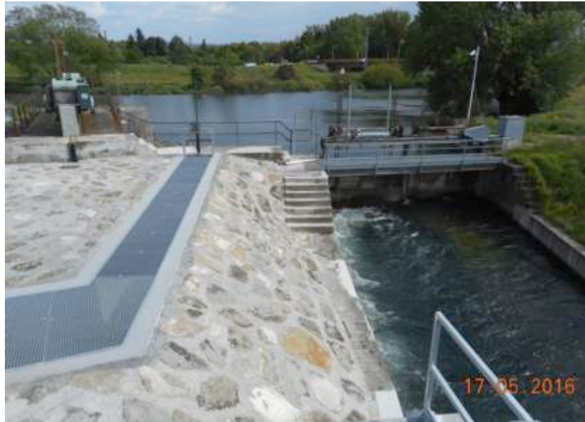
Abbildung 22 Einlaufbauwerk Spratzern nach der Sanierung 32
