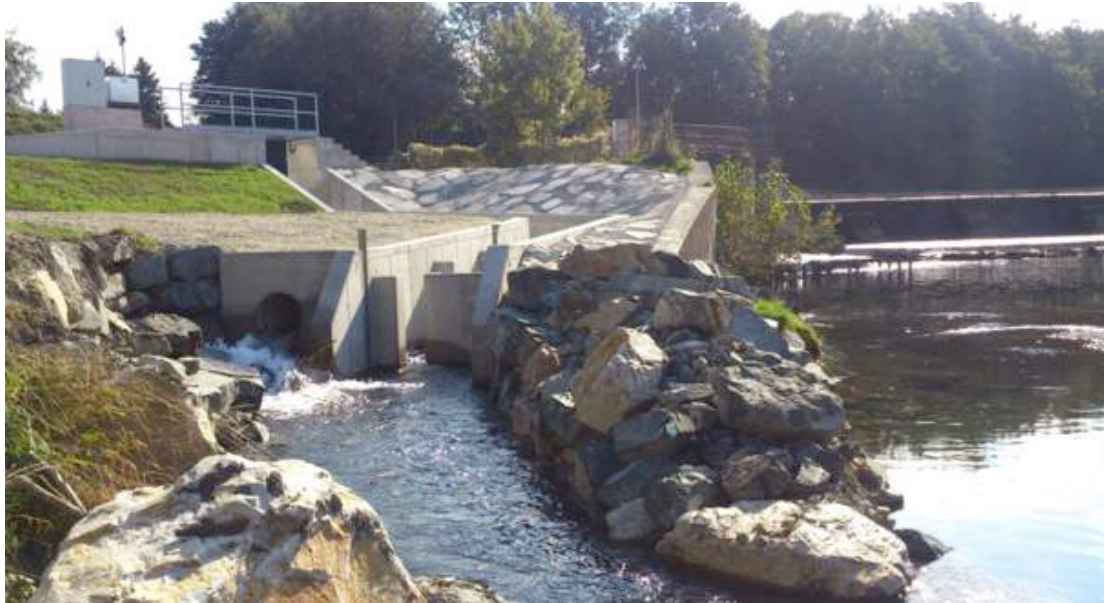
Abbildung 28 Sanierte Altmannsdorfer Wehr und Fischaufstieg 39
