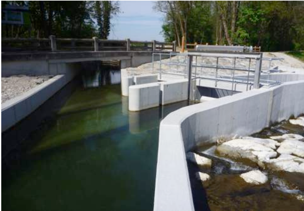
Abbildung 24 Sanierte Wolfswinkel Wehr mit Fischaufstieg 34
