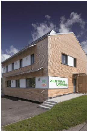
Zentrum Umwelt : Musterbeispiel für Althausmodernisierung, Büro des Bezirksabfallverbandes Freistadt
