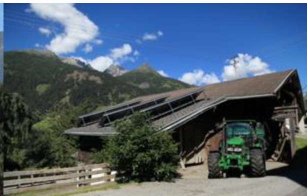
Abb. 48: Solaranlage in der Landwirtschaft in Großkirchheim, © B. Krobath
