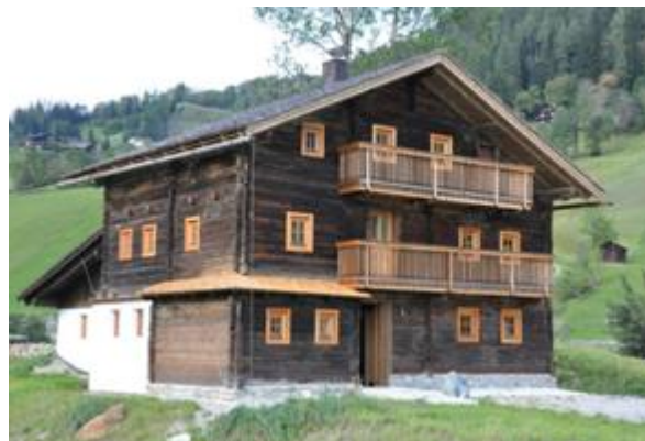
Abb. 34: Mentlhaus in Großkirchheim, © Gde. Großkirchheim
