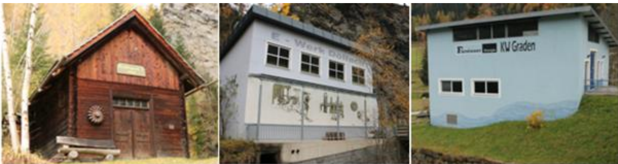
Abb. 38: Hist. Kraftwerk Döllach, © H. Schober Abb. 39: E-Werk Döllach, © M. Suntinger Abb. 40: KW Graden/Fürstauer Energie GmbH, © M. Suntinger
