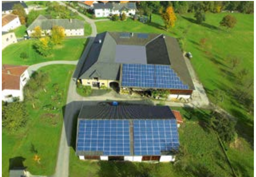
FOTO: HELIOS SONNENSTROM GMBH
