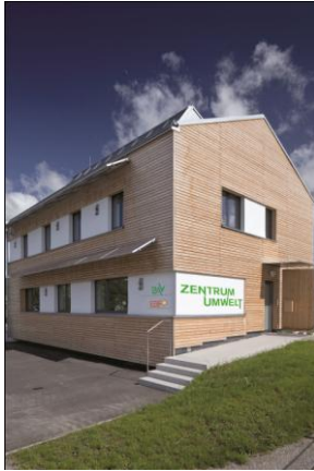
Zentrum Umwelt: Musterbeispiel für Althausmodernisierung, Büro des Bezirksabfallverbandes Freistadt und des EBF
