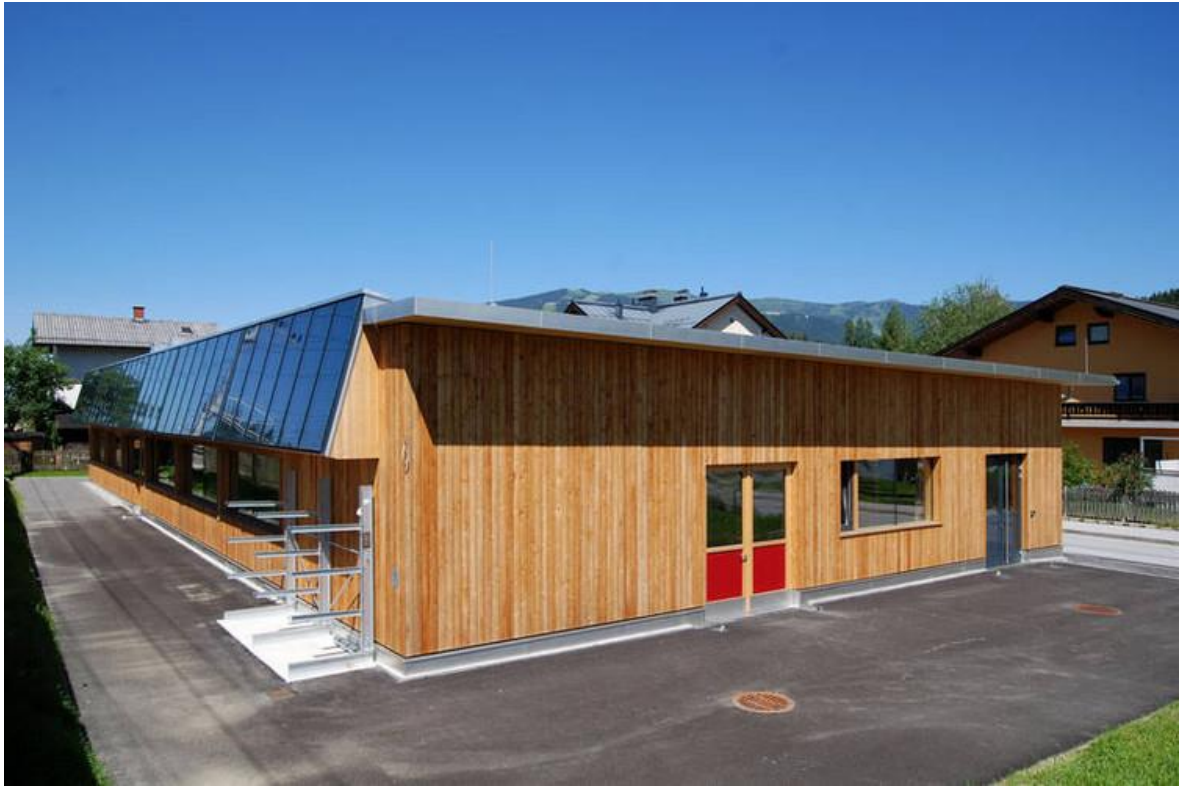
Holzbearbeitungswerkstatt mit einer reinen Sonnenheizung
