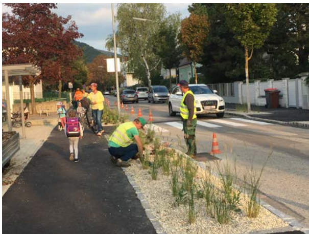
Foto Koch; Rückbau Radetzkystraße vor Volksschule; Projekt Weiki-Mobil
