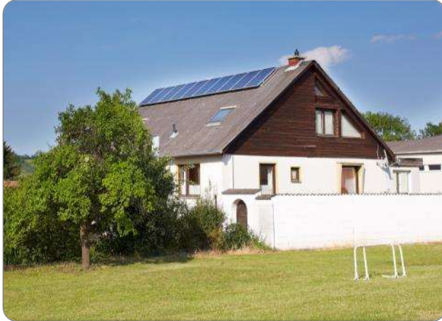
Abbildung 36 Photovoltaikanlagen in der Region 6
