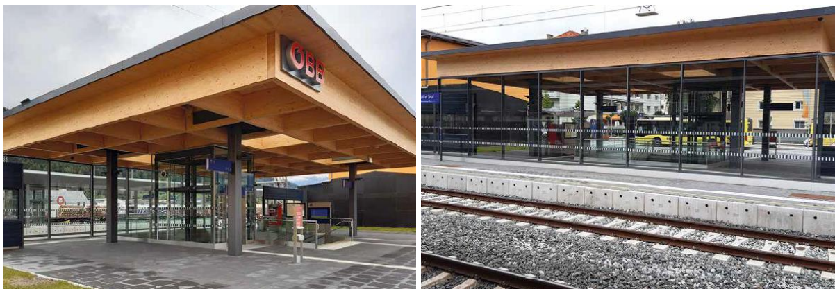
Abbildung 4: Bahnhof Hall in Tirol Zugangsbauwerk von 2017
