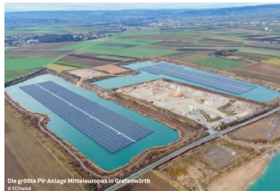
Abbildung 22: Die größte PV-Anlage Mitteleuropas, Quelle: ECOwind
