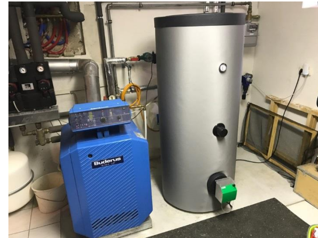
Warmwasser Speicher + Wärmepumpe
