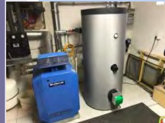
Warmwasser, Wärmepumpe + Wärmespeicher
