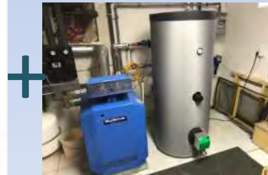
Warmwasser Speicher + Wärmepumpe
