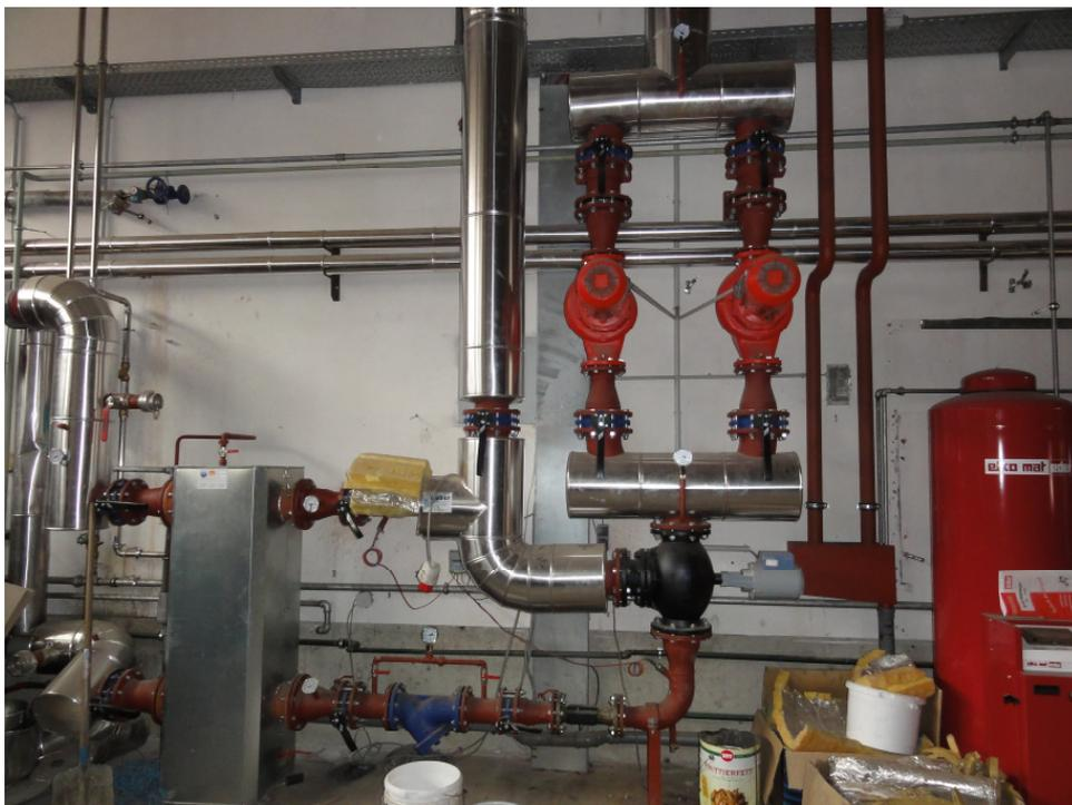
**Abbildung 7: Einbindepunkt in bestehendes Wärmenetz**
