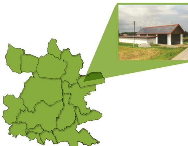
Abbildung 22: Biomasse-Heizwerk in Bildein (Bildnachweis: EEE GmbH)
