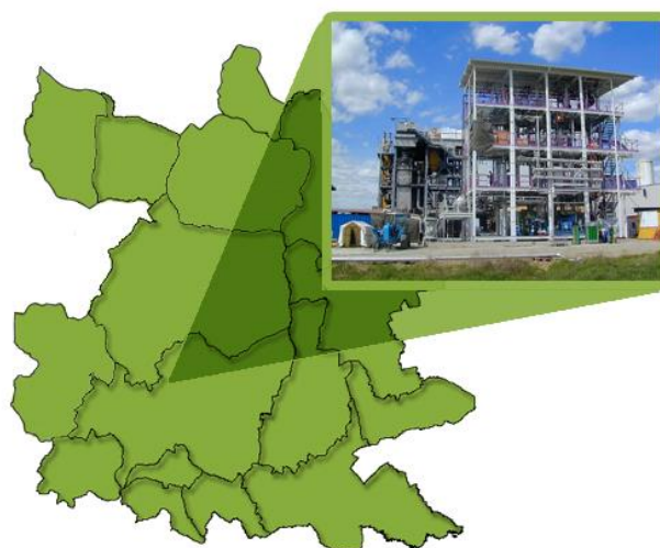
Abbildung 12: Methanierungsanlage (Forschungsanlage zur Erzeugung von BioSNG) in Güssing (Bildnachweis: EEE GmbH)
