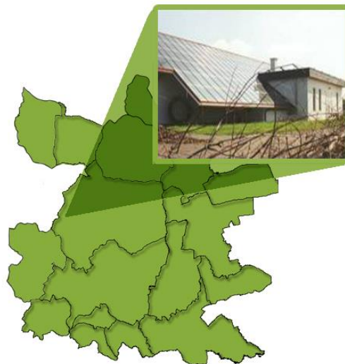
Abbildung 19: Biomasse-Heizwerk in Deutsch Tschantschendorf (Bildnachweis: EEE GmbH)
