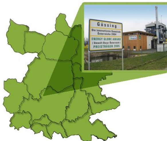
Abbildung 10: Biomassekraftwerk Güssing (Bildnachweis: EEE GmbH)
