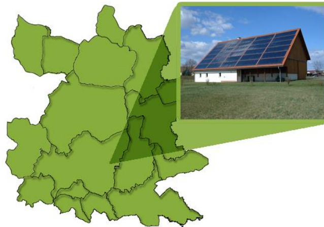
Abbildung 6: Solarthermie-Anlage auf dem Dach des Biomasse-Heizwerkes Urbersdorf (Bildnachweis: EEE GmbH)
