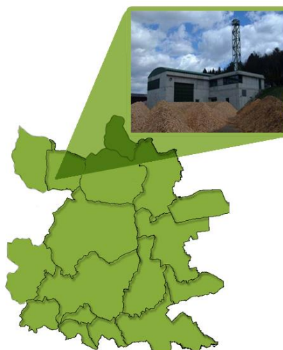
Abbildung 23: Biomasse-Heizwerk in Güttenbach (Bildnachweis: EEE GmbH)
