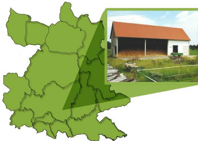
Abbildung 17: Biomasse-Heizwerk in Glasing (Bildnachweis: EEE GmbH)
