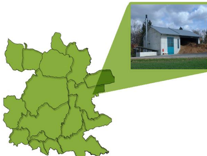
Abbildung 21: Biomasse-Heizwerk in Eberau (Bildnachweis: EEE GmbH)
