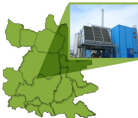
Abbildung 13: „Biostrom“-Anlage, Biomasse-Dampfkraftwerk in Güssing (Bildnachweis: EEE GmbH)
