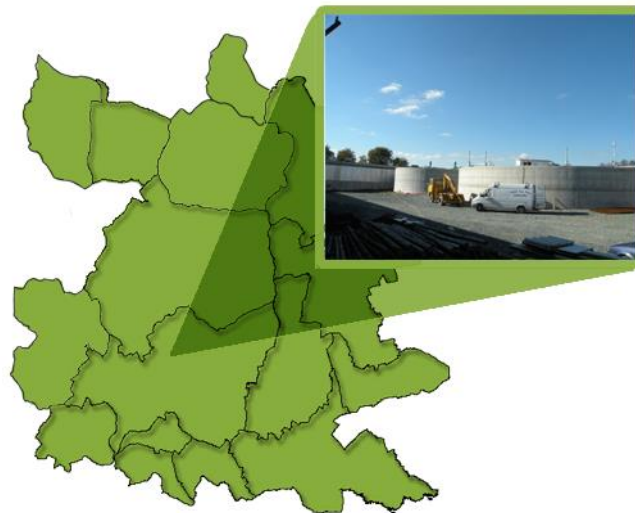
Abbildung 14: Biogasanlage Wolf in Güssing (Bildnachweis: EEE GmbH)
