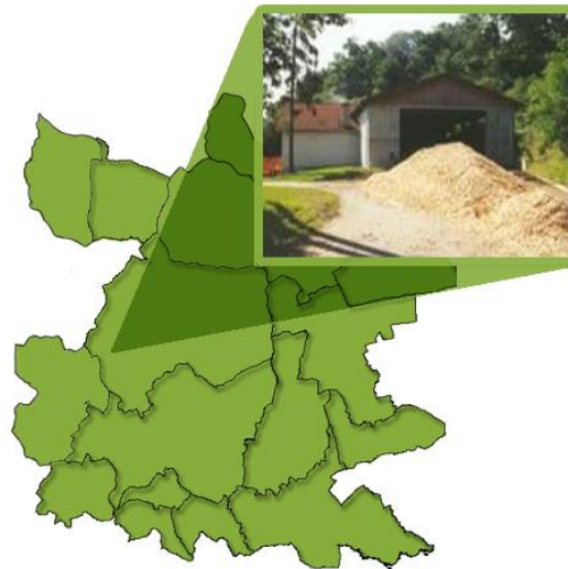
Abbildung 20: Biomasse-Heizwerk in Kroatisch Tschantschendorf (Bildnachweis: EEE GmbH)
