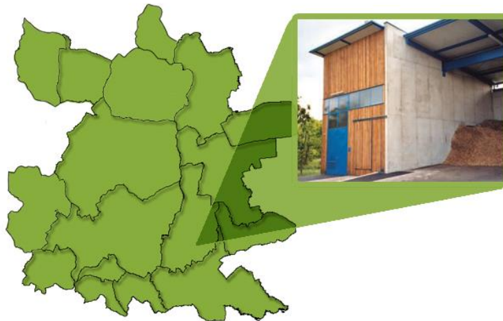
Abbildung 16: Biomasse-Heizwerk in Strem (Bildnachweis EEE GmbH)
