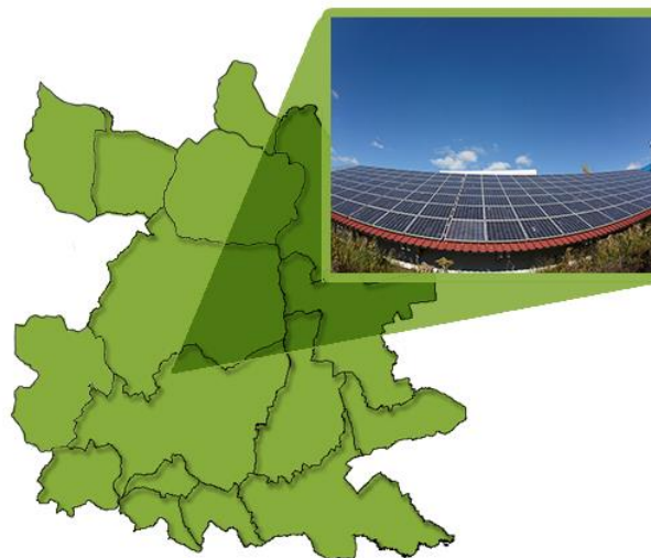
Abbildung 5: Photovoltaik-Anlage Güssing (Bildnachweis: EEE GmbH)
