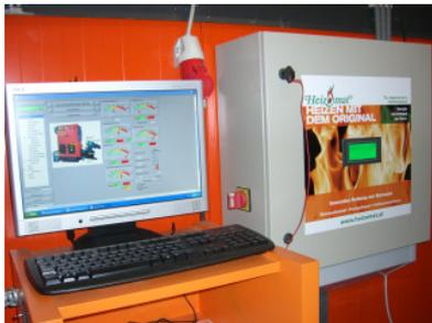
Abbildung 32 Steuerung des Heizwerkes
